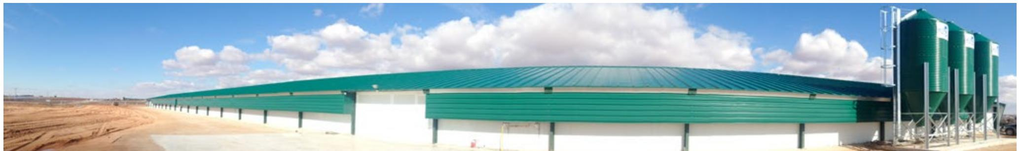
Faldón fabricado con Chapa Prelacada y Tubo Galvanizado, atornillado a la Estructura, con el objeto de controlar las entradas de aire evitando las influencias negativas del viento, para conseguir una ventilación óptima.
