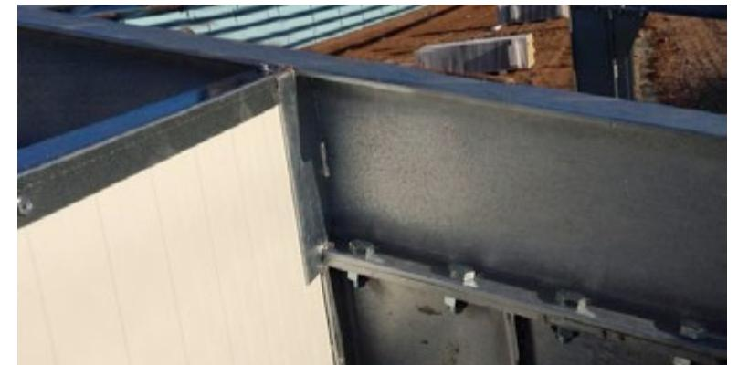
Correas de chapa galvanizada atornilladas sobre la estructura.
