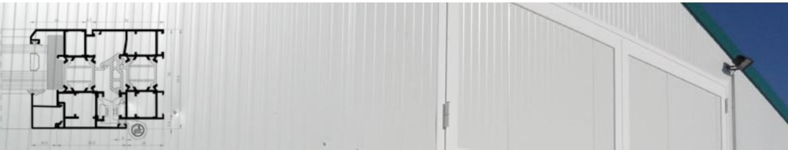
Puertas entrada de personal laterales y vehículos pesados, fabricados con Perfil de Aluminio de 80mm., y puente de rotura térmico, triple cierre de caucho y Panel Sandwich, de este modo conseguimos una total estanqueidad y un máximo aislamiento.
