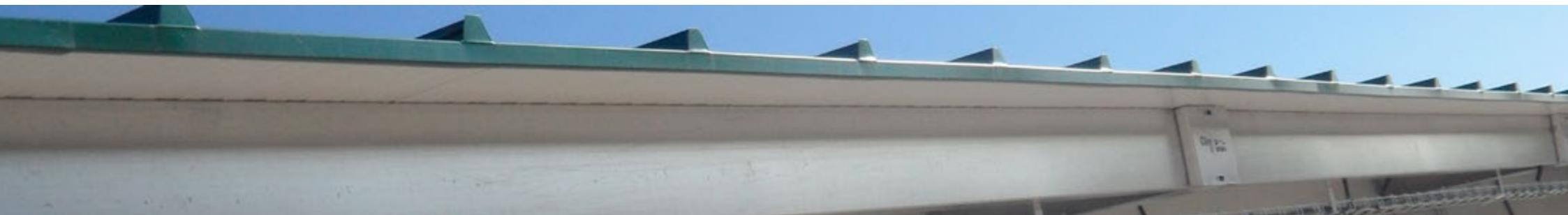
Cubierta de Panel con aislamiento de poliuretano de alta densidad y dos chapas lacadas, con pendiente del 20/25%, atornillado sobre correas con cumbre troquelada y remate punta-panel, evitando el deterioro del poliuretano tanto por agentes atmosféricos como por plagas.
